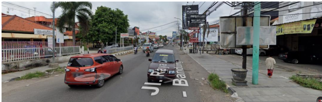
Gambar 1. 2 Kondisi Jalan dan pedestrian Jalan Tuparev
