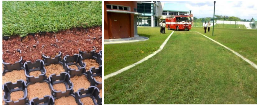
Gambar 4. 7 Drainage cell membantu memperkuat permukaan dan peresapan air hujan ke dalam tanah.
