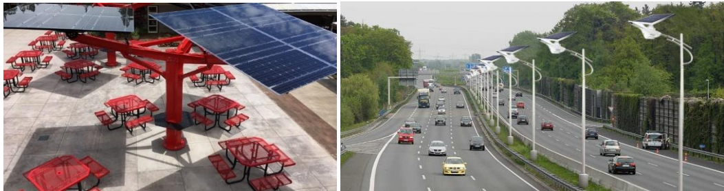
Gambar 4. 4 Panel surya yang dimanfaatkan juga menjadi pembentuk bayangan di hari yang terik.
