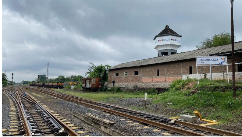
Gambar 4.4 Bangunan Menara Air Sindanglaut
