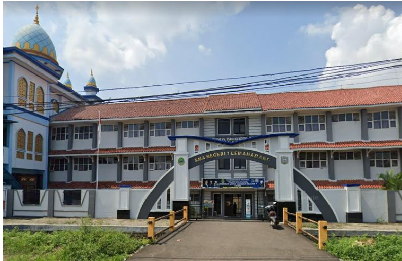
Gambar 4.6 Bangunan SMAN 1 Lemahabang
