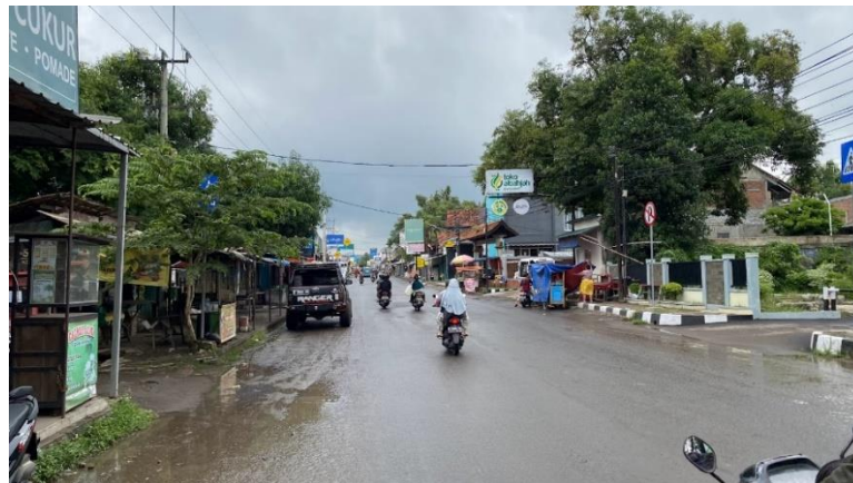
Gambar 4.9 Kondisi Jalan MT. Haryono
