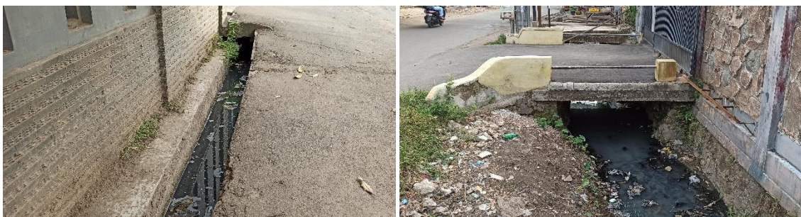
Kondisi Jaringan Drainase Tersier Ruas Jalan Cideng Raya
